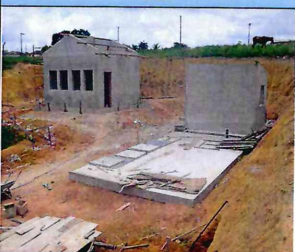
EVOLUÇÃO DA OBRA - CASA DE MAQUINAS - BASE REATOR UASB + BASE TANQUE BIOFILTRO AERÓBICO - POÇO SUCÇÃO - LABORATÓRIO
