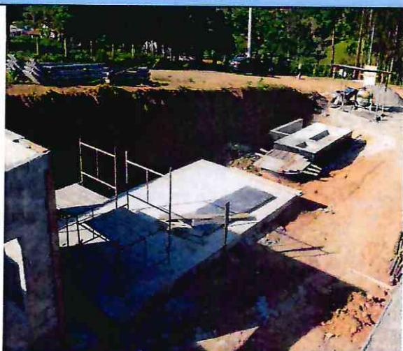
EVOLUÇÃO DA OBRA - CASA DE MAQUINAS - BASE REATOR UASB + BASE TANQUE BIOFILTRO AERÓBICO - POÇO SUCÇÃO - ELEVATÓRIA
