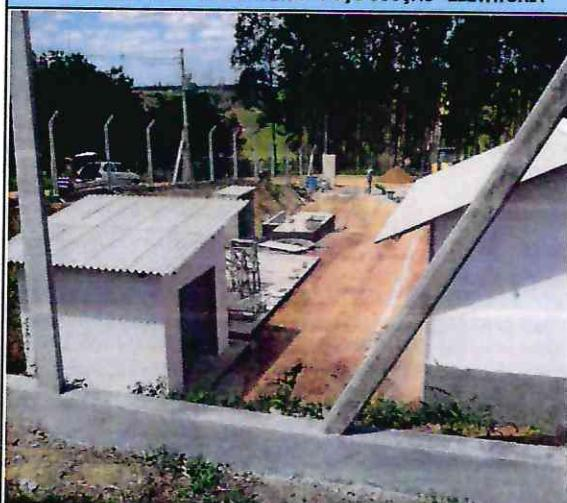
EVOLUÇÃO DA OBRA - CASA DE MAQUINAS - BASE REATOR UASB + BASE TANQUE BIOFILTRO AERÓBICO - POÇO SUCÇÃO - LABORATÓRIO
