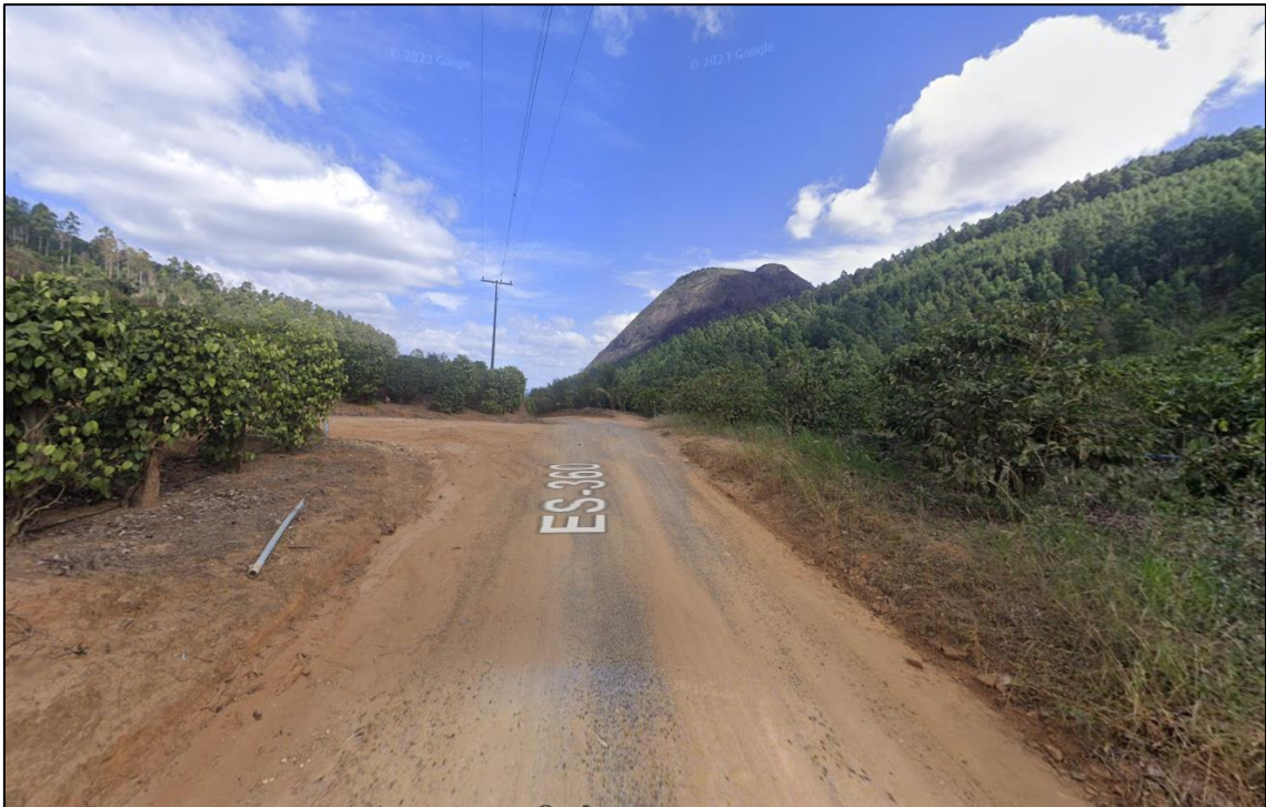
FINAL DE UM TRECHO A SER PAVIMENTADO DE (338544,28 m E 7863559,21 mS)
