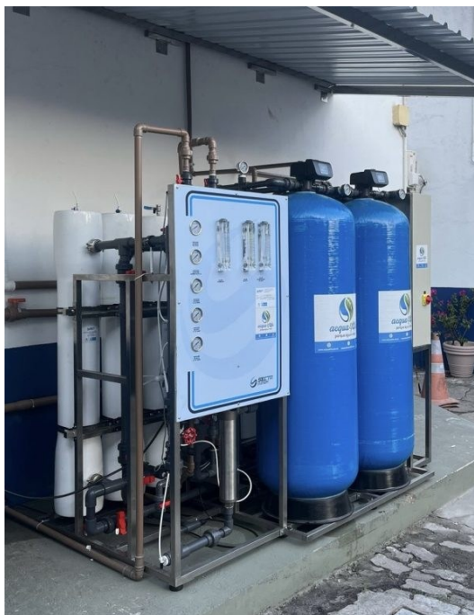
Imagem 01 - Modelo representativo de Eta com membranas de Ultrafiltração
